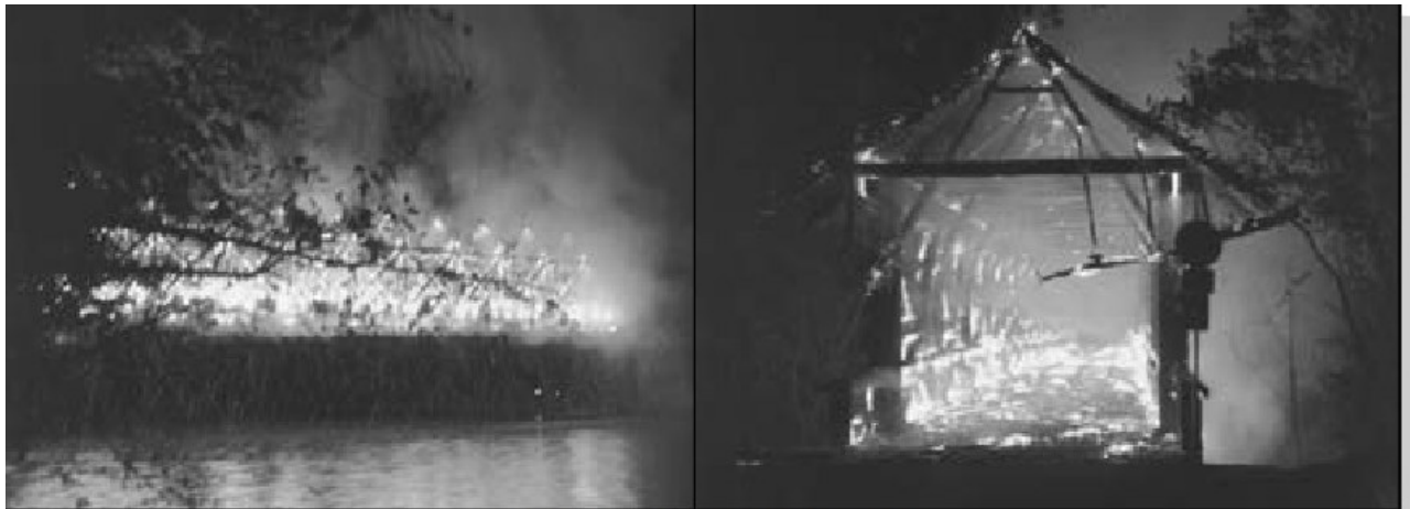
Vollbrand Holzbrücke „Hölzener Steg“
