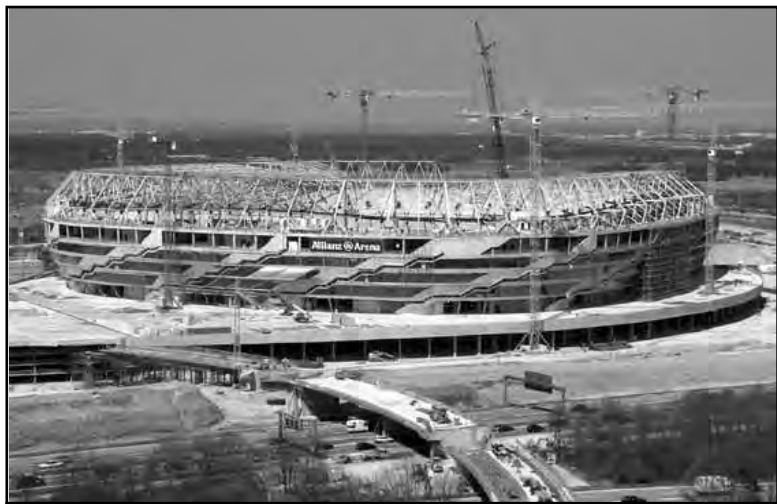
Baustelle neues Stadion
