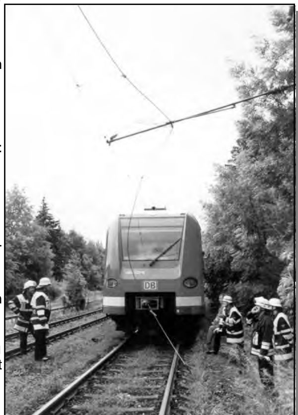
Fahrdrahtbruch S-Bahnhof Engelschalking
